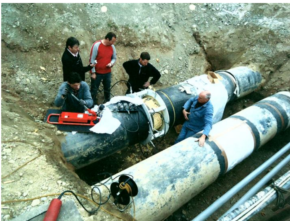
Abbildung 29: Scherfestigkeitsuntersuchungen an der Leitung; Quelle: Steirische Gas-Wärme
